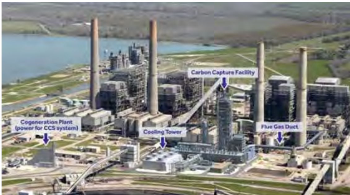
Figuur 14-7: Layout van de CO 2 -afvanginstallatie van de Petra Nova steenkoolcentrale in Texas (VS) (Bron: U.S. Energy Information Administration)
